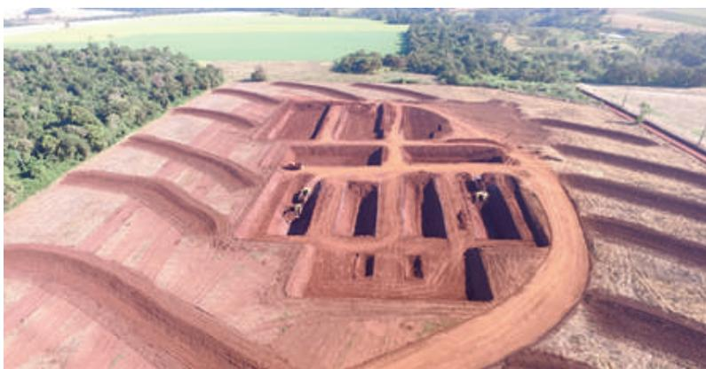
El proyecto inicial consiste en el movimiento de suelo que consistió en excavaciones de las lagunas para tratamiento de efluentes y el terraplenado para el área de plataformas para los distintos galpones.
