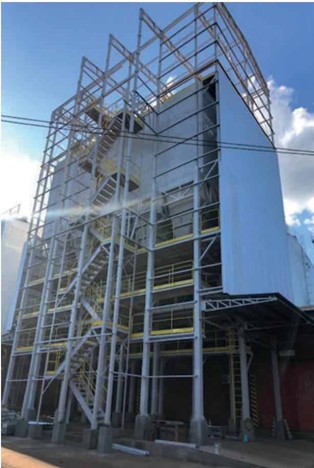
**Tolvas de expedición a granel con balanza de pesaje y sistema de abastecimiento a graneleros automatizados.**
